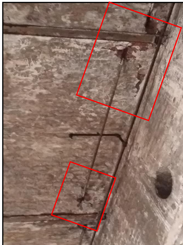
PLATE 4 : DE-LAMINATION OF CHUNK.
